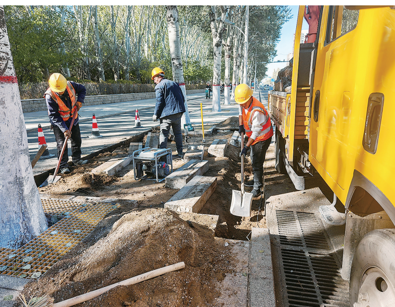
“道路管家”对新星壹品小区南门附近的马路牙子进行“降阶”施工。
