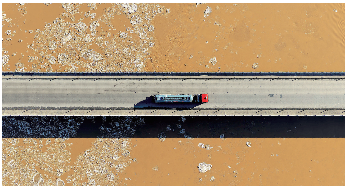
黄河大桥下的流凌。
