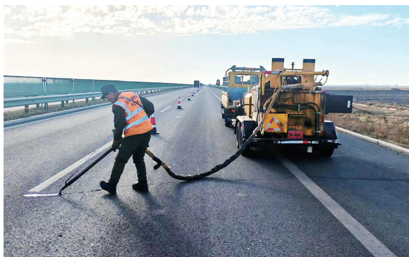
施工作业现场。
